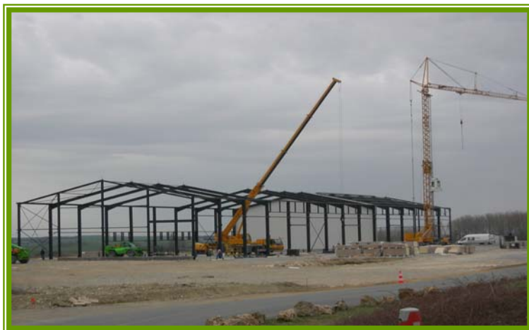
Bâtiment en cours de construction - Avril 2010
